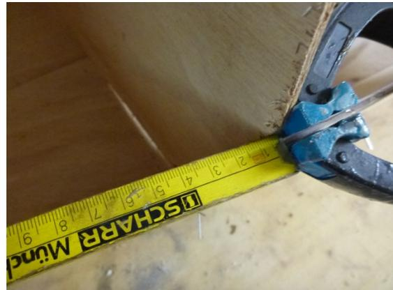
Wenn das Spant zwei benachbarte Planken spreizt, dann muss es etwas nach hinten versetzt werden. Gibt es dagegen einen Spalt zwischen Spant und Planke, dann muss das Spant leicht nach vorn gerückt werden.
