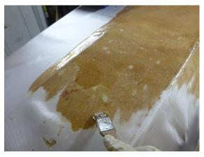
... Luftblasen, Nasen und Pfützen sind egal. Nach ein paar Minuten ist das Gewebe und das darunterliegende Holz nass. Nochmal drüberpinseln oder –rollen, um die letzten Luftblasen zu entfernen:
